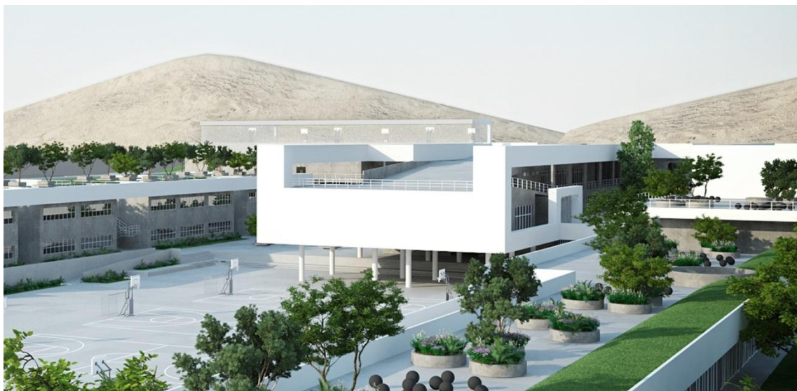
VISTA AÉREA DEL PROYECTO
