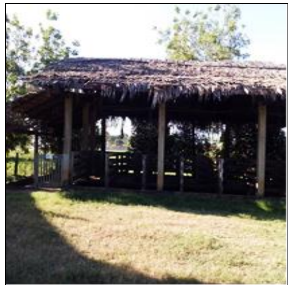
Figura 3 - Galpão em madeira
