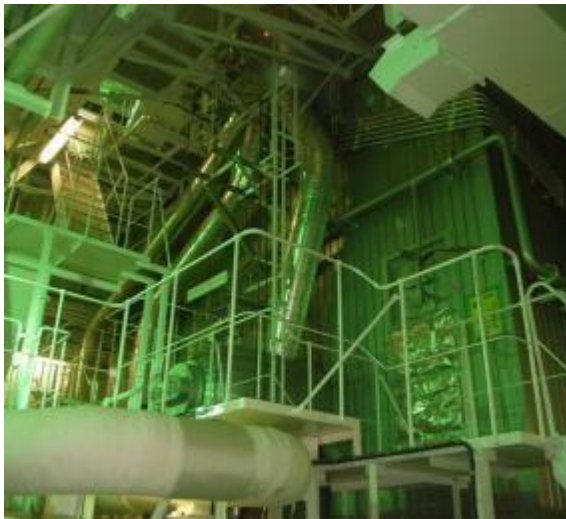
Ilustración 42: Vista exterior de la caldera con recalentamiento. Fuente: Mitsubishi Heavy Industries.
