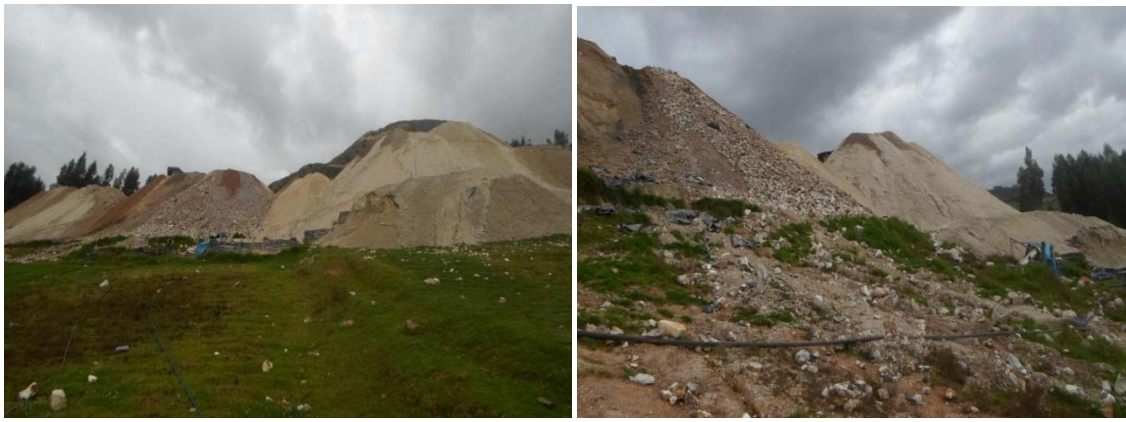
Fig. 14 y 15: Vista de los relaves salinas 2 y 3 y la inadecuada ejecución de su almacenamiento
