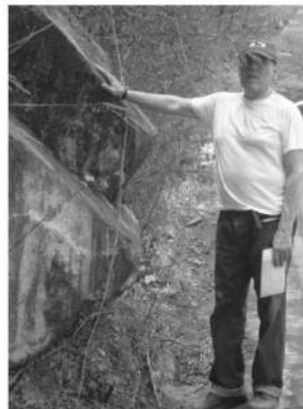
Figura 19: Inmediaciones de la Presa Santa Rosa
