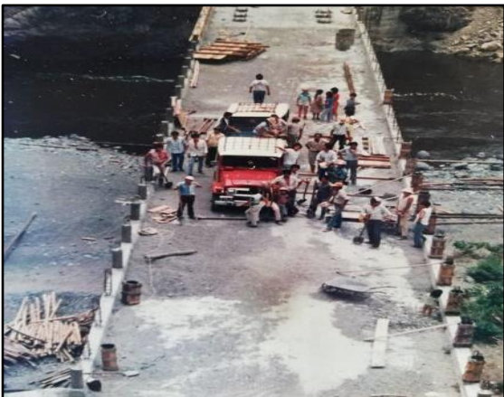
Figura 82. Avance de la construcción del puente Junín en 1988. Fuente: Escobar, 2020.
