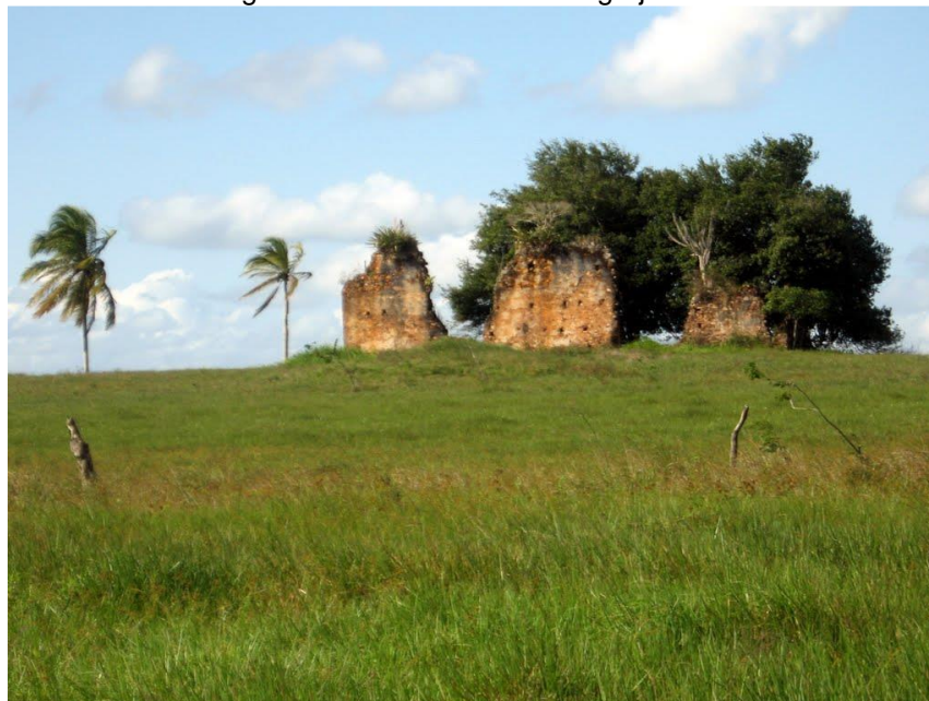
Imagem 3: Foto das ruínas da Igreja Velha.
