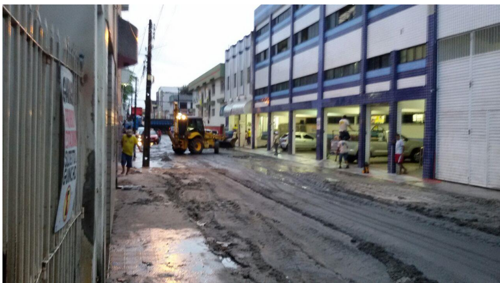
Imagem 29: Situação da reconstrução do pavimento.
