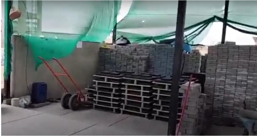
Ilustración 1: Apilamiento de bloquetas
