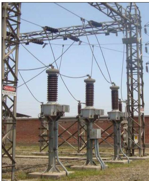
**Figura 25.** Transformadores de tensión barras 60Kv
