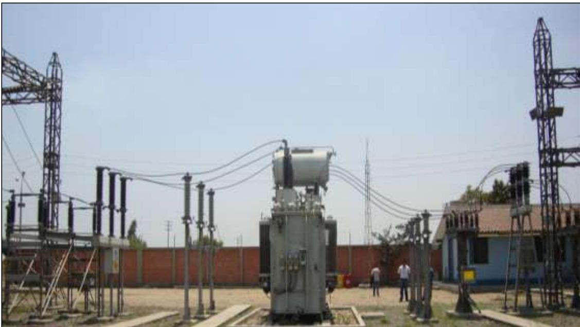
**Figura 26.** Transformador de potencia y bahía asociada
