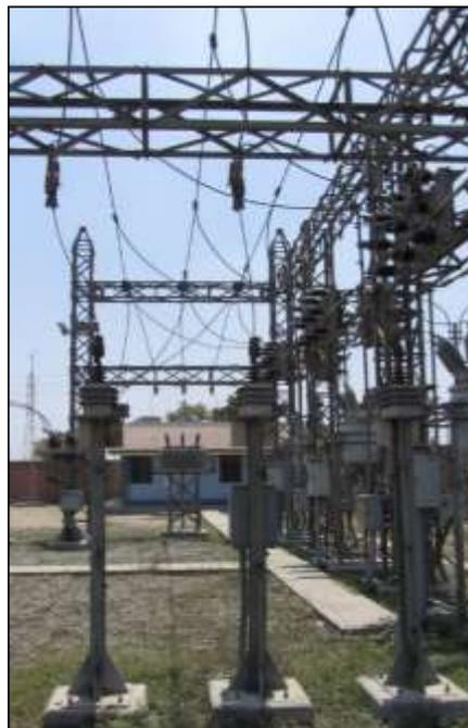
**Figura 29.** Transformador de tensión barras 22,9Kv
