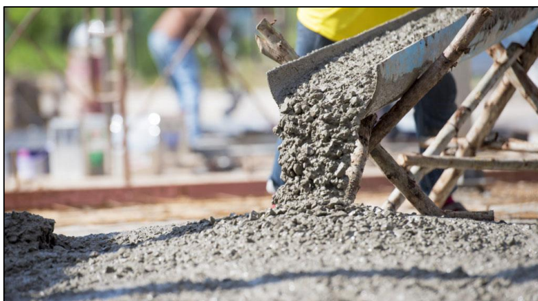
Figura 8. Concreto en estado plástico
