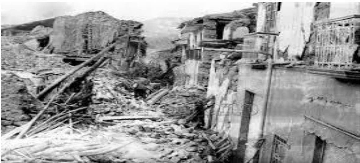
Figura 49 Escombros de viviendas de la Ciudad de Yungay
