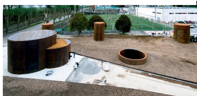
Figura 21 Recuperación y construcción - MIL
