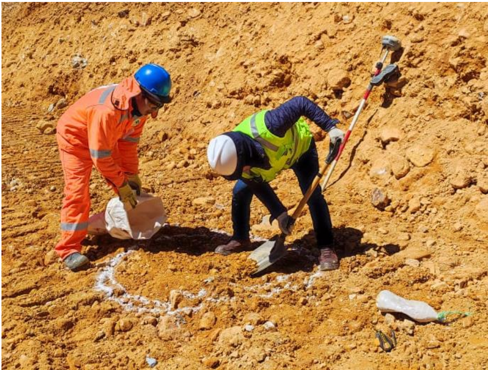
Figura 37 Excavación calicata 3 prog. 3 + 800
