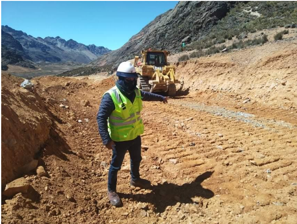
Figura 29 vía del distrito de Carampoma
