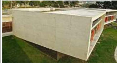
Figura 25: Concreto expuesto en las fachadas
