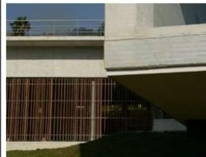
Figura 26: Paneles móviles en la fachada del conector
