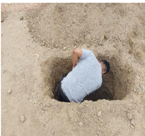
Figura Nª 08: calicata C3-M1 Fuente: elaboración propia,2022.
