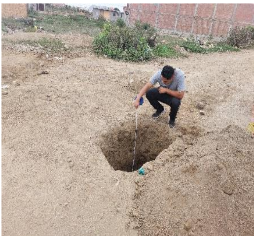
Figura Nª 06: calicata C1-M1 Fuente: elaboración propia,2022.
