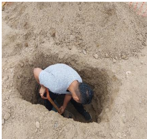
Figura Nª 07: calicata C2-M1 Fuente: elaboración propia,2022.
