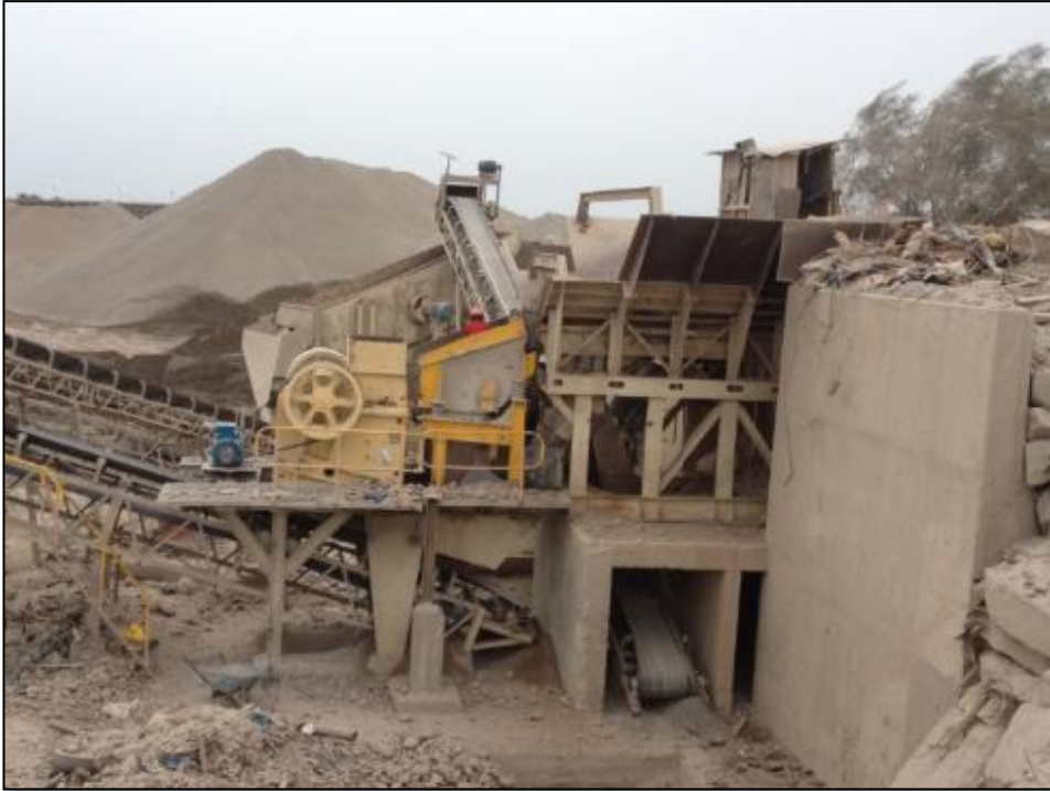
Figura 16. Maquina chancadora y tolva alimentadora
