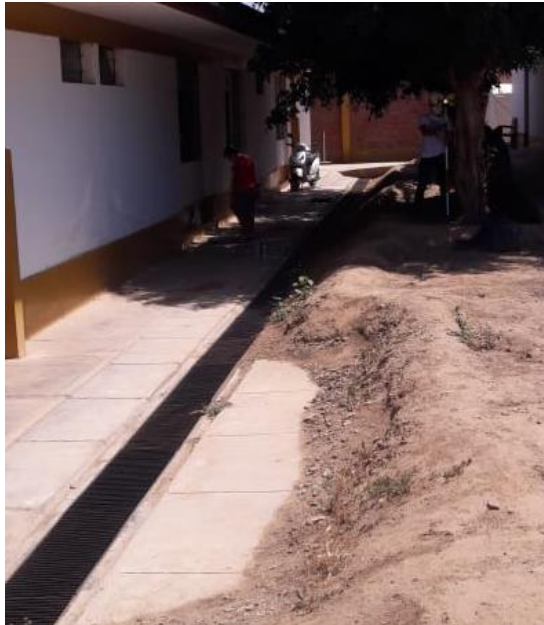
Figura 44: Estado actual - Consultorios Fuente: Elaboración propia
