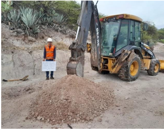
Imagen 01: Excavación de Calicata C-01
