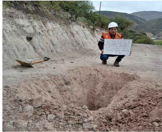
Imagen 02: Excavación de Calicata C-02
