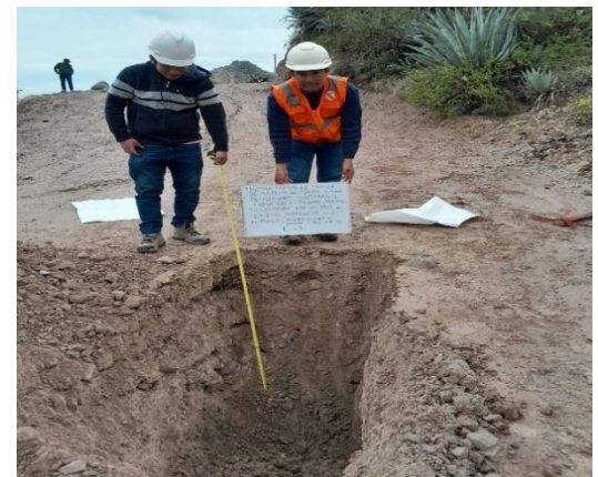
Imagen 04: Excavación de Calicata C-04
