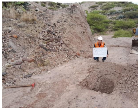
Imagen 03: Excavación de Calicata C-03
