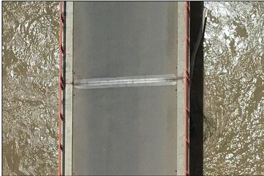
Figura 74. Vista en planta de la junta 5 (tramo 4 y tramo 5).
