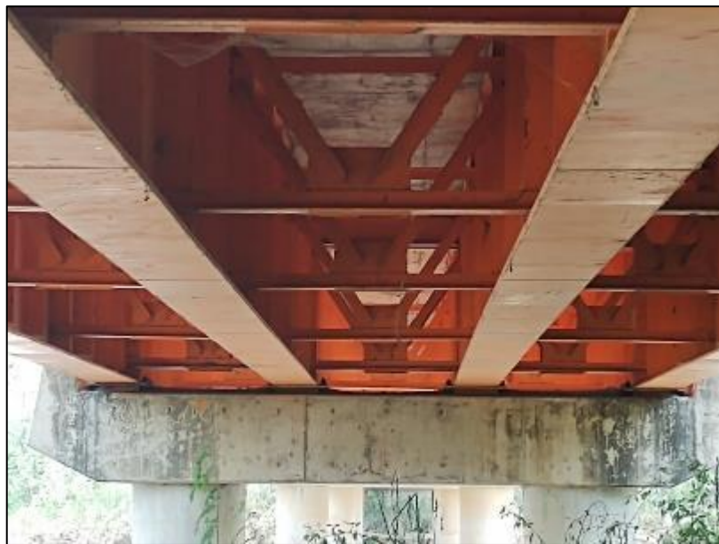
Figura 23. Vista de vigas diafragma con arriostres interiores (tramo 3, 4, 5 y 6).
