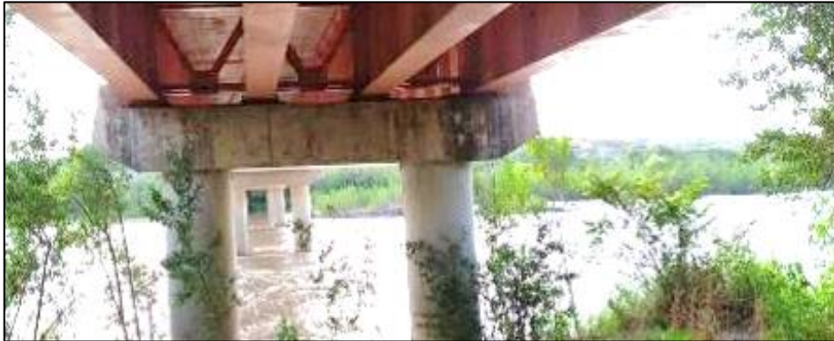
Figura 37. Vista de los pilares de concreto armado en funcionamiento.
