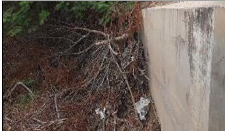
Figura 32. Losa de concreto armado (refuerzo longitudinal) del puente Francos, vista al tramo 3 y 4.
