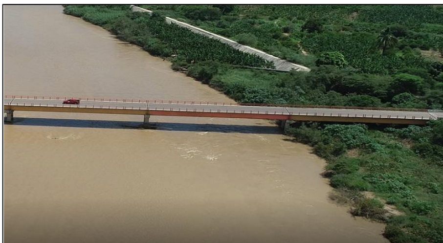
Figura 92. Vista lateral del puente Francos del tramo 4, 5 y 6.
