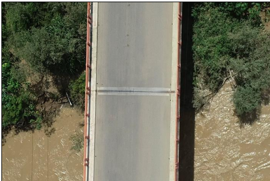
Figura 75. Vista en planta de la junta 6 (tramo 5 y tramo 6).
