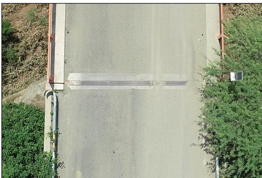
Figura 69. Vista en planta de la junta 1 (tramo 1)
