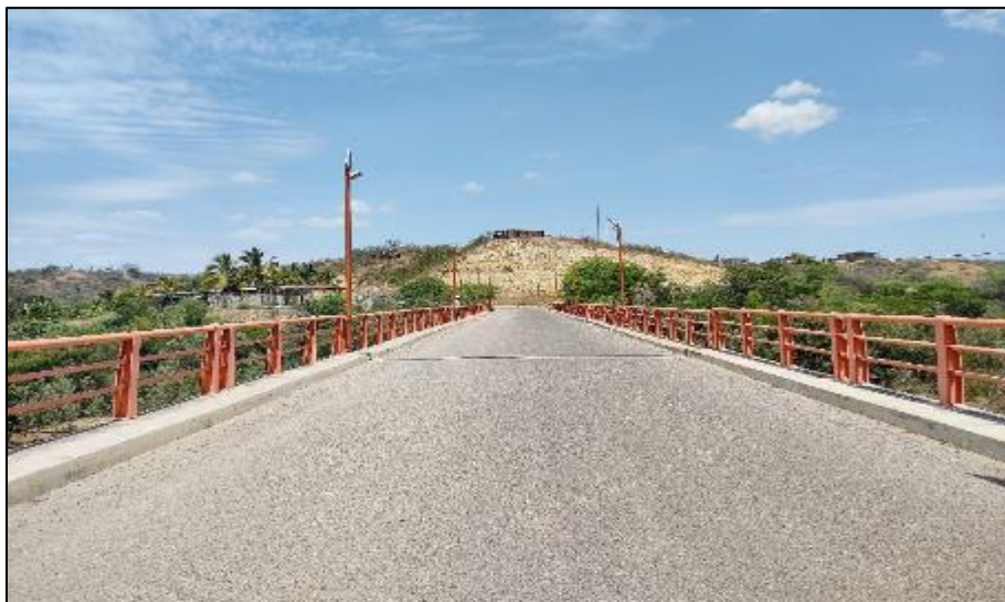
Figura 48. Vista a detalle de la capa de asfalto del puente Francos.
