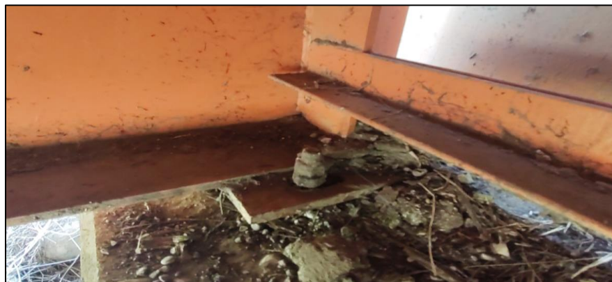
Figura 68. Apoyo deslizante de neopreno en el estribo derecho.
