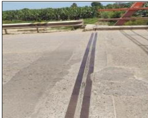
Figura 77. Junta 7 de tipo compresible / expandible, entre estribo derecho y tramo 6.
