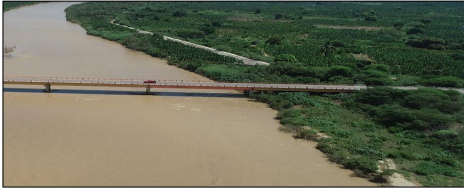
Figura 94. Señalización del puente Francos.
