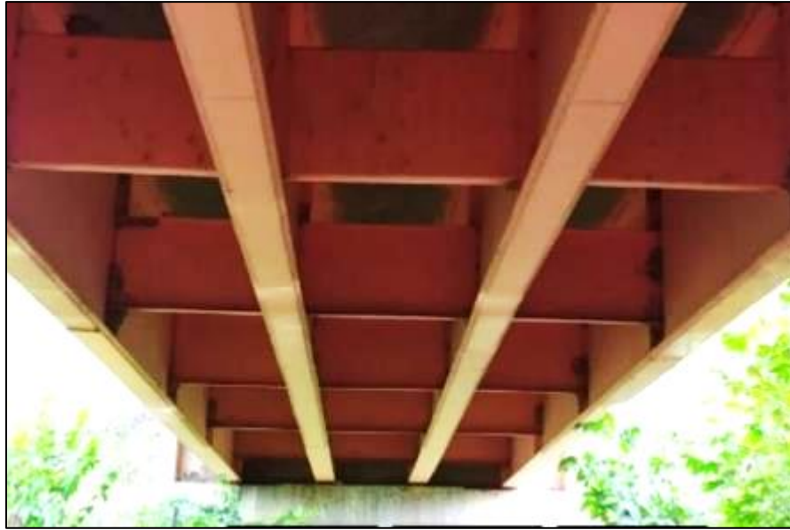
Figura 22. Vigas diafragma de sección transversal C.
