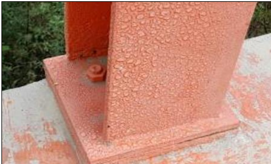
Figura 81. Perno de fijación de baranda.
