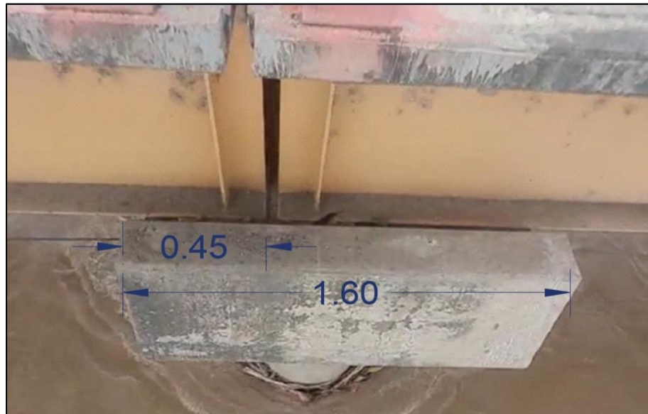
Figura 45. Detalle de extremos de vigas en el pilar 3, aguas arriba.
