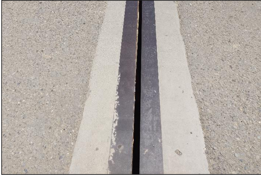
Figura 72. Vista en detalle de la junta 3 (tramo 2 y tramo 3).
