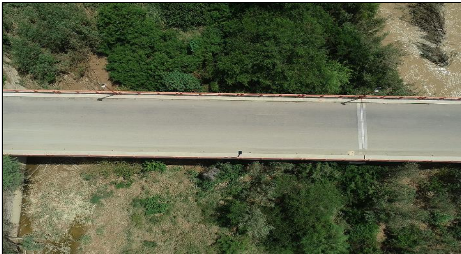
Figura 84. Lecho del río del puente Francos.
