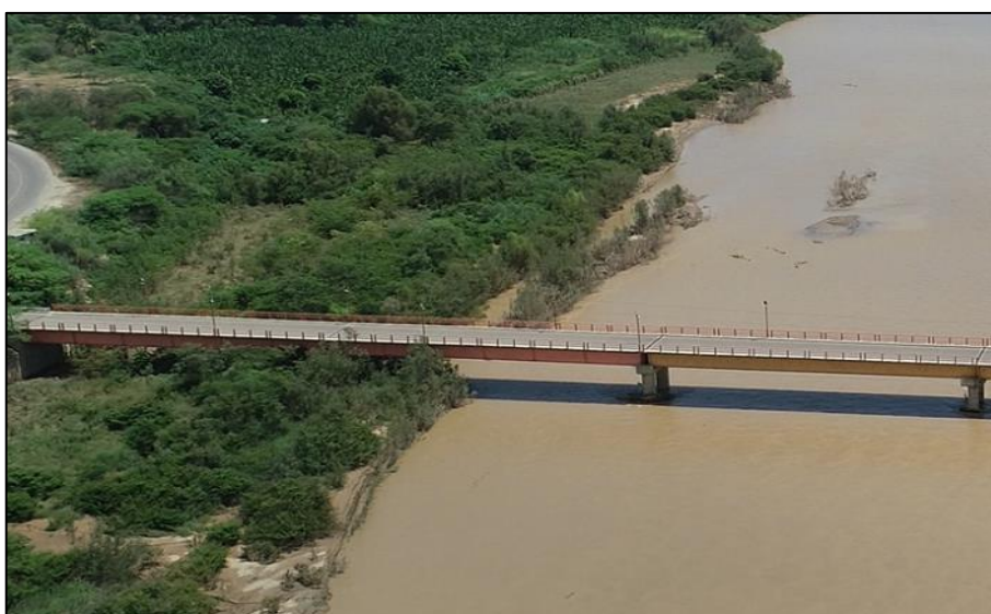
Figura 91. Vista lateral del puente Francos del tramo 1, 2 y 3.
