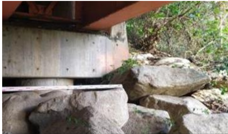
Figura 28. Presencia biológica, suciedad, polvo y humedad.
