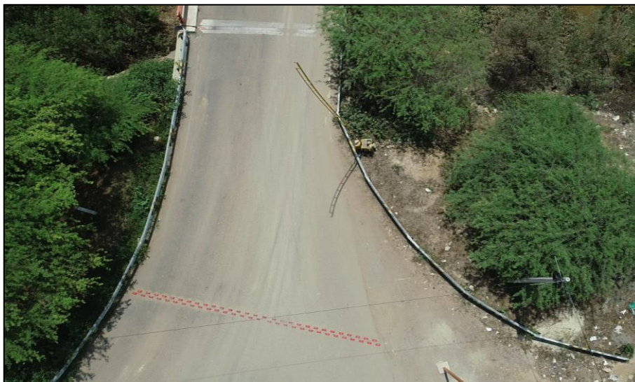
Figura 90. Vista en planta de la entrada del puente Franco.
