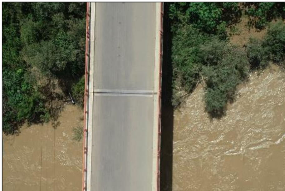
Figura 54. Vista en planta de capa asfáltica del quinto y sexto tramo.
