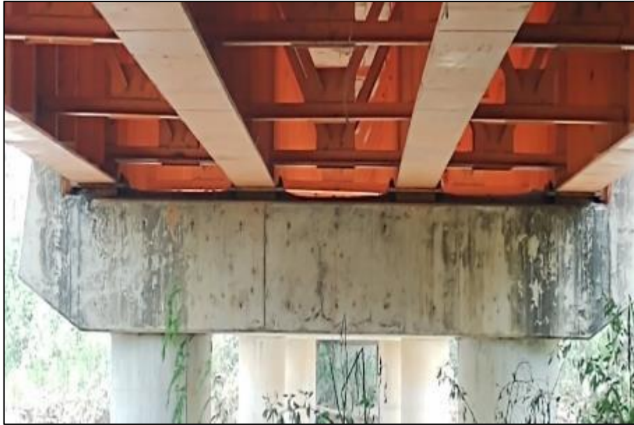
Figura 61. Apoyos fijos y apoyos deslizantes de neopreno del pilar 5 derecho del puente Francos.
