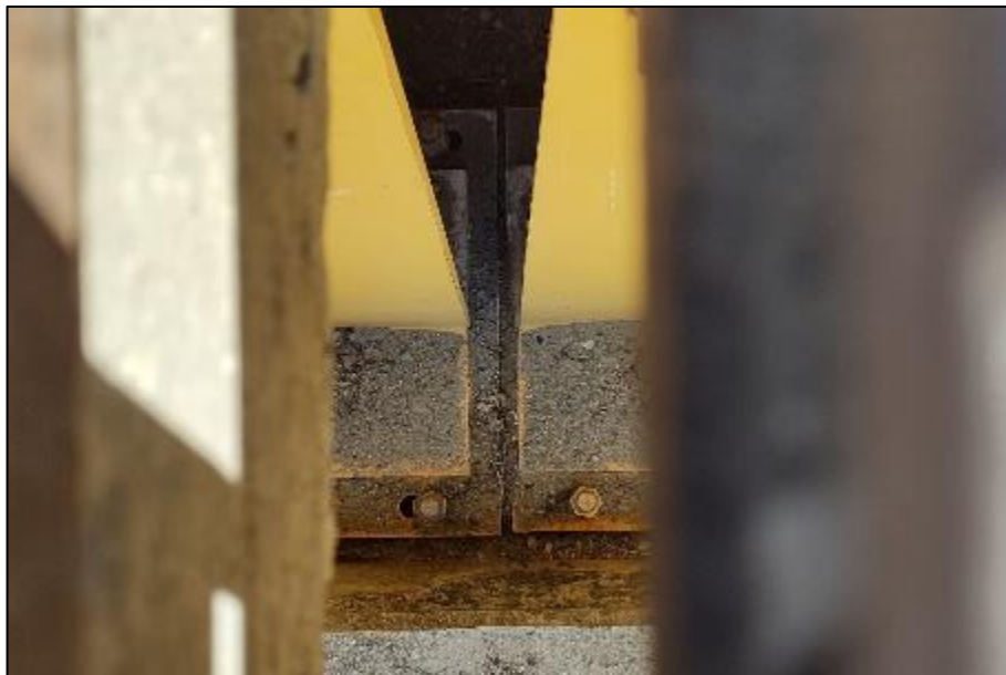
Figura 62. Vista de los apoyos (deslizante y fijo) en el pilar 4, entre tramo 4 y 5, aguas arriba, del puente Francos.
