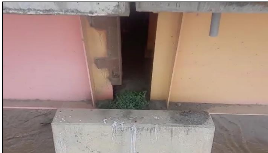
Figura 44. Detalle de extremos de vigas en el pilar 2, aguas abajo. Presencia de vegetación en los cabezales de los pilares.
