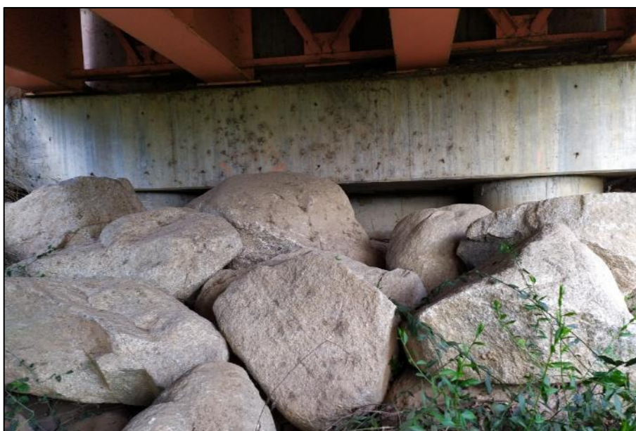
Figura 85. Enrocado de la margen izquierda del río del puente Francos.
