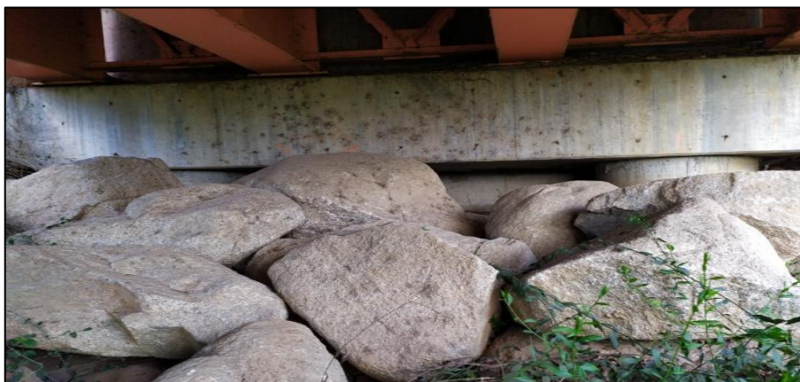
Figura 89. Enrocado de la margen izquierda del río del puente Francos.
