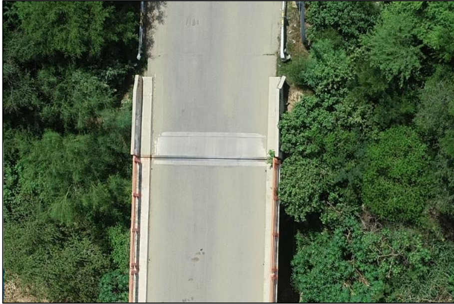
Figura 76. Vista en planta de la junta 7 (tramo 6 y tramo 7)
