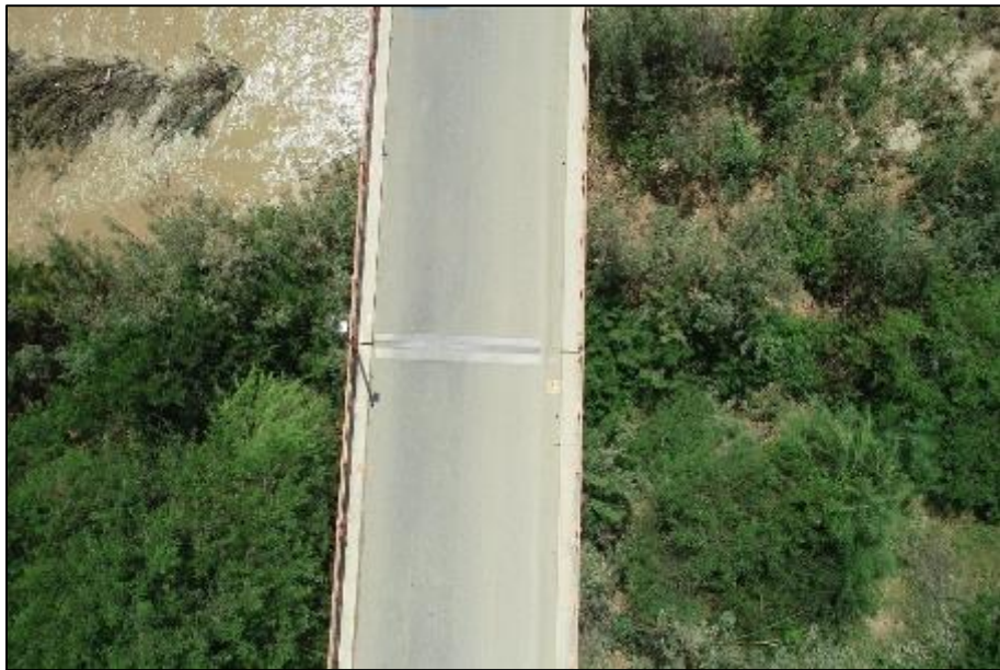
Figura 50. Vista en planta de capa asfáltica del primer y segundo tramo.
