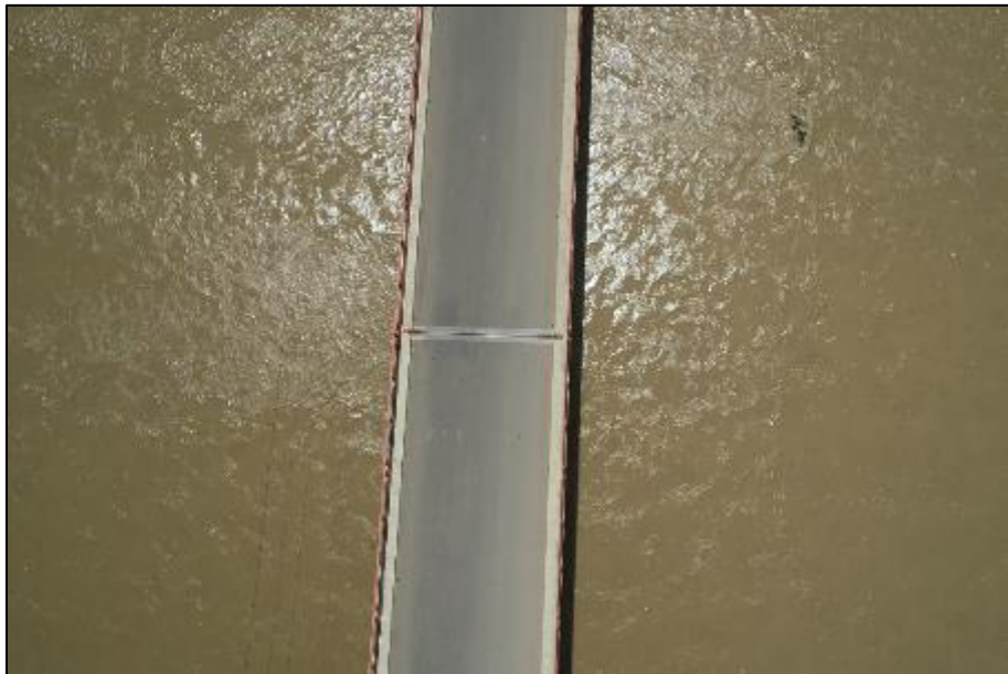
Figura 52. Vista en planta de capa asfáltica del tercer y cuarto tramo.
