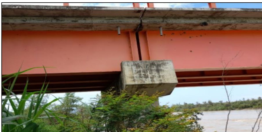
Figura 82. Drenaje de tuberías PVC del puente Francos.
