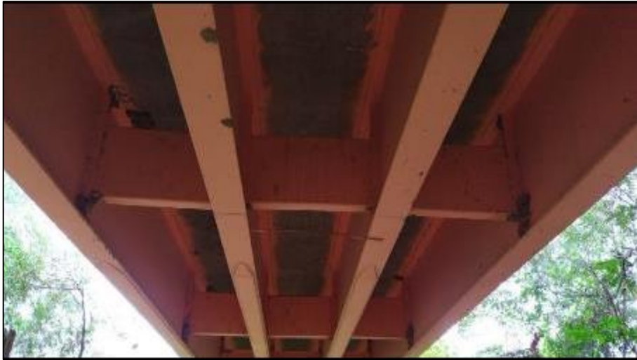
Figura 7. Losa de concreto armado que forma parte de la sección compuesta del tablero junto con cuatro vigas de acero tipo plate grider.
