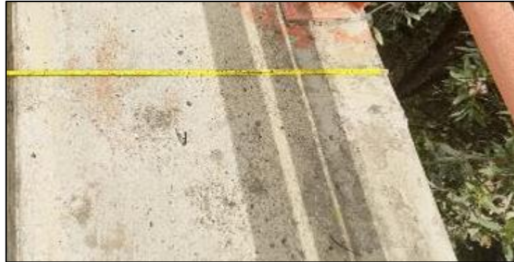
Figura 55. Vereda de concreto del puente Francos.
