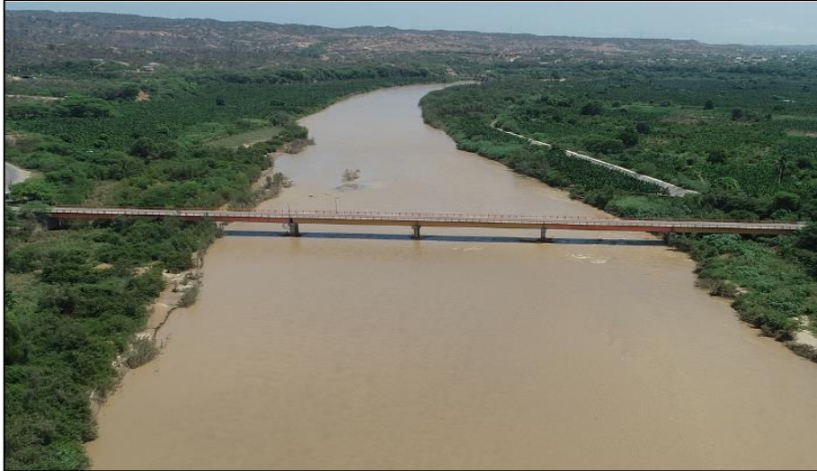
Figura 83. Márgenes del río del puente Francos.
