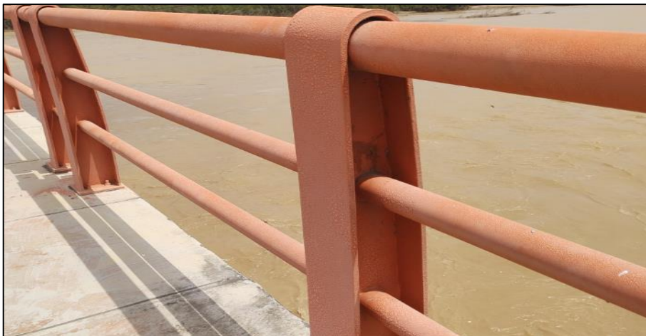
Figura 79. Barandas de acero del puente Francos.
