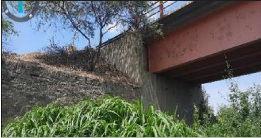
Figura 26. Vista de estribo izquierdo del puente.
