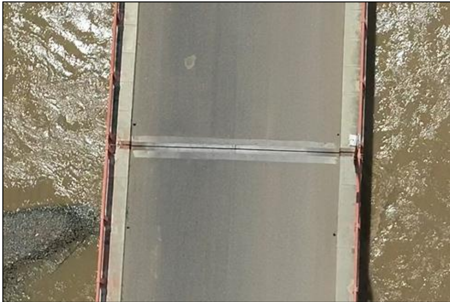
Figura 71. Vista en planta de la junta 3 (tramo 2 y tramo 3)
