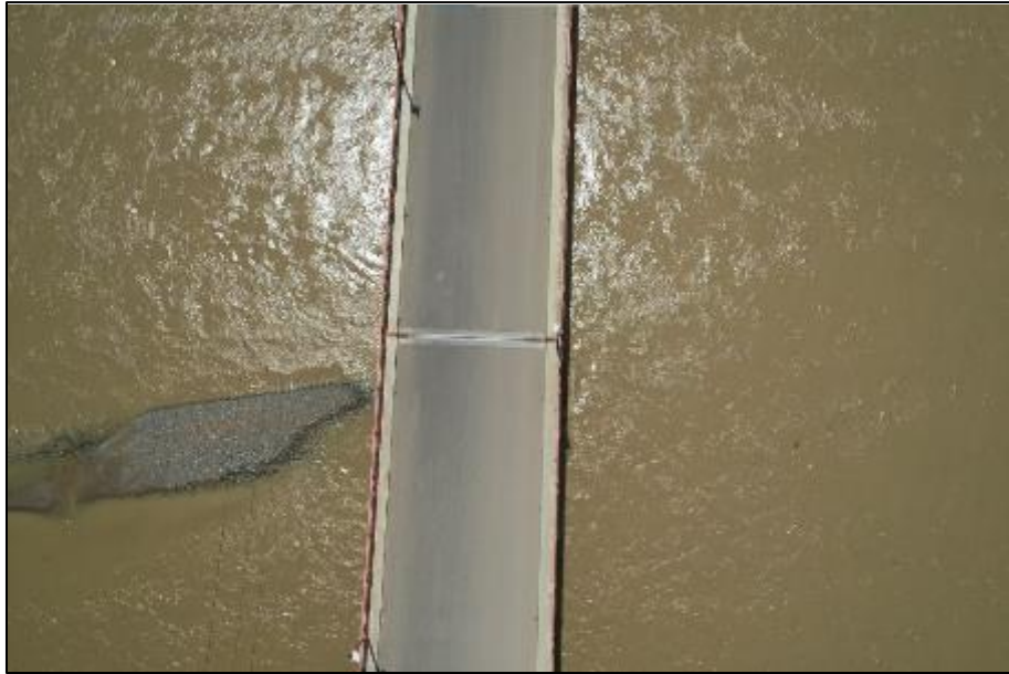
Figura 51. Vista en planta de capa asfáltica del segundo y tercer tramo.
