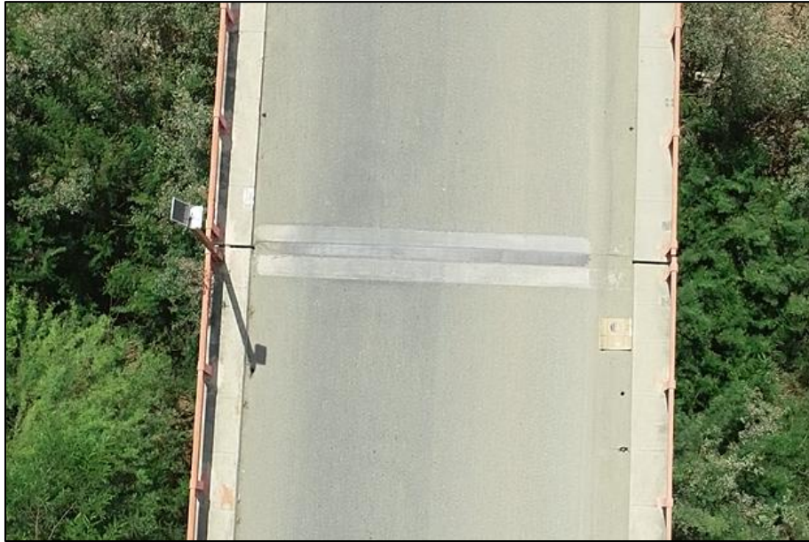
Figura 70. Vista en planta de la junta 2 (tramo 1 y tramo 2)
