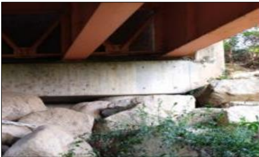
Figura 27. Vista del estribo derecho del puente.
