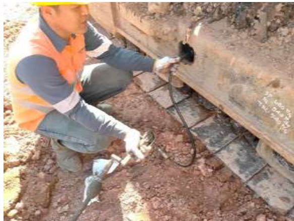
Gambar 12. Mengencangkan Track Assembly
