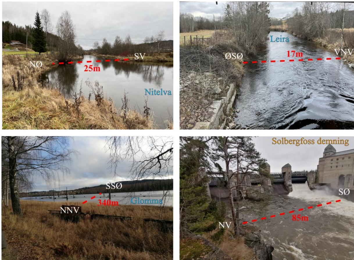
Figur 5. 2: Nitelva med 25 m bredde, Leira med 17 meter bredde og Glomma med 340 meter bredde. Solbergfoss demning dekker hele elven rett etter utløpet til Øyeren. Demningen er plassert der Glomma er på sitt smaleste nedstrøms Øyeren. Foto: Severin Skattum.
