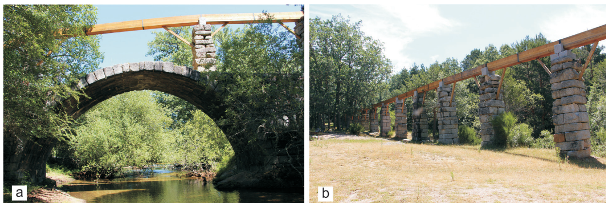
Figura 11 Diferentes vistas del acueducto del Puente de los Canales (M. Mejías).
