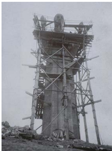
Andamiaje de la construcción del Cristo del Otero.
