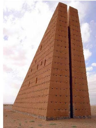
Vista de la escalera por la parte posterior, orientación Este.
