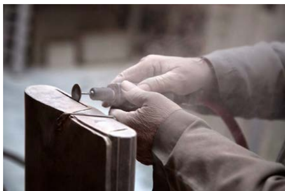
Corte con disco de espárrago. Ejecución de una Carpeta.
