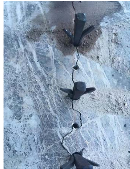
Desprendimiento de la piedra con cuñas de hierro acerado.
