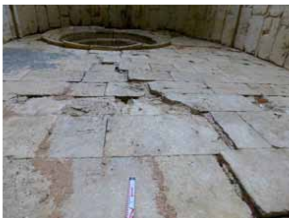
Figura 5: Fractura penetrativa en el muro oeste de la iglesia de Quintanilla-Sobresierra (Burgos).
