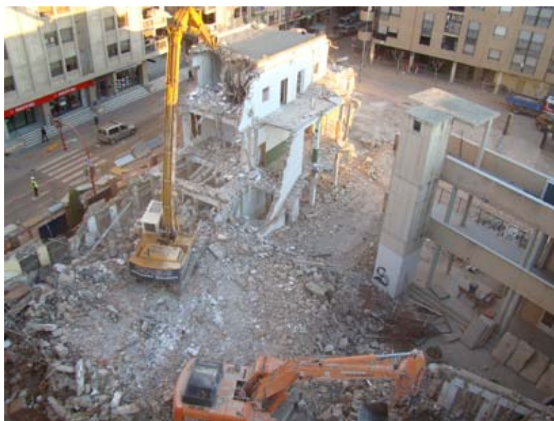
Fig. 6. Demolición del I.E.S. Ramón Arcas Meca de Lorca.
