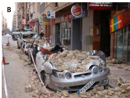
Fig. 1. A. Aspecto de la Avenida Juan Carlos I, minutos después del terremoto principal de Lorca del 11 de mayo. B. La caída de elementos no estructurales de los edificios causaron el mayor número de víctimas mortales y heridos, así como cuantiosos daños materiales.
