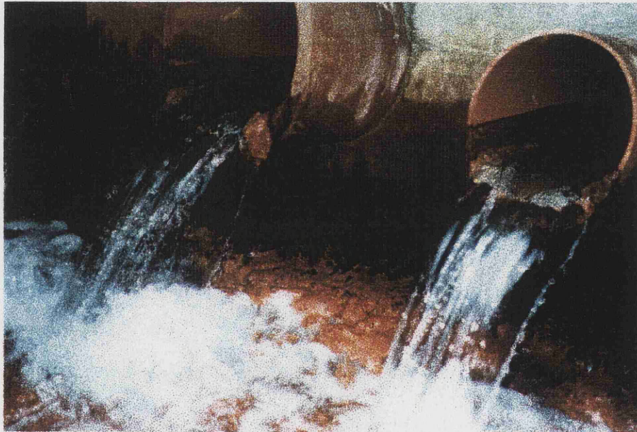
Fotografía 9. Caños de la boca norte de la mina.
