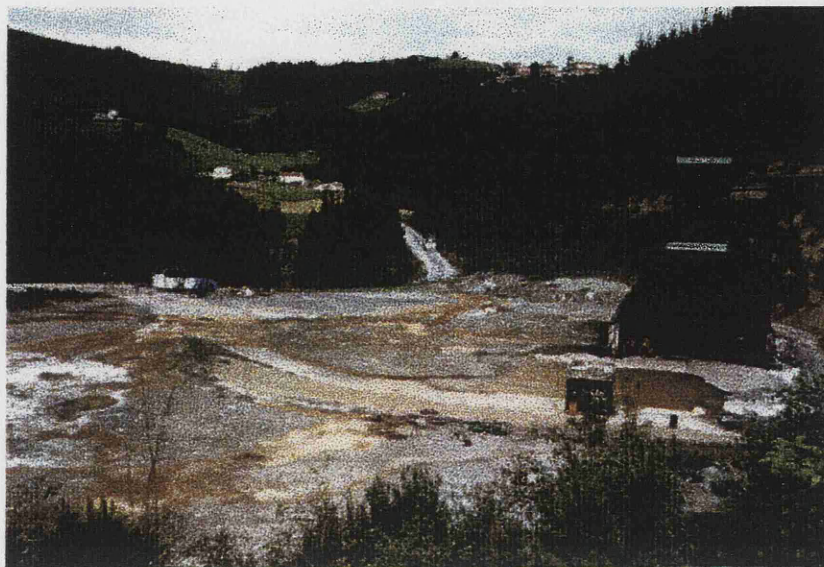
Fotografía 5. Depósito de concentrados de cinc. Junto a los caseríos del fondo discurre el río Estanda.
