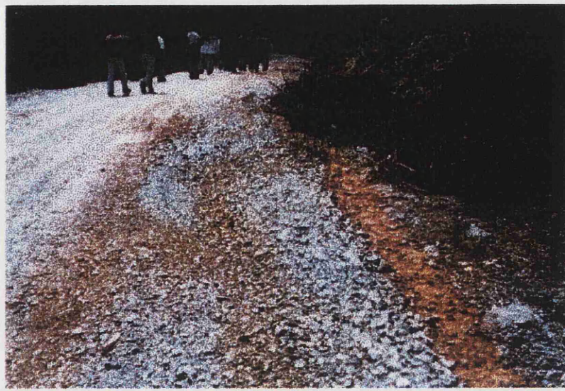
Fotografía 2. Una de las carreteras de la explotación. Lixiviación de piritas por el arcén.
