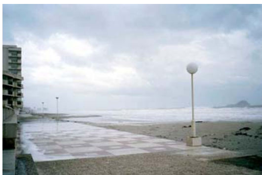
Fig. 11. Efecto del oleaje de tormenta sobre la playa. La entrada del mar se ve favorecida por la existencia de los corredores de deflación generados entre los edificios. (La Manga del Mar Menor, Murcia).
