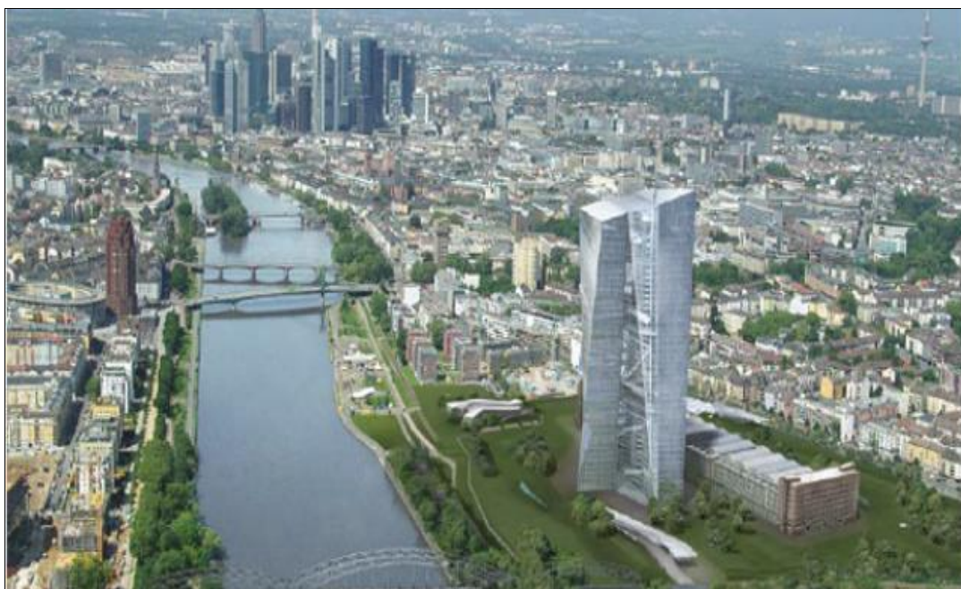
Sede central del BCE en Frankfurt (Alemania)
