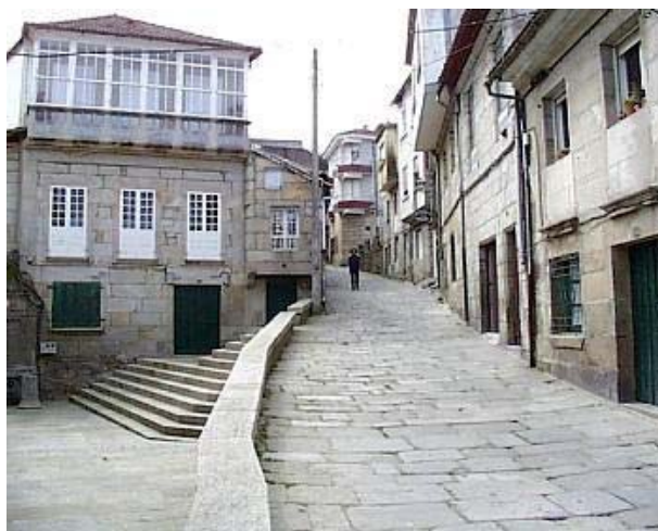
Foto 5.8: Rua Fonte de Ceta rehabilitada.
