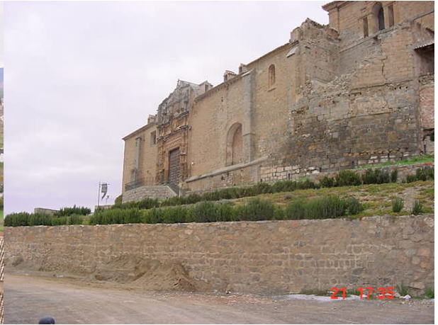
Acceso a Santa María y rehabilitación del inmueble.
