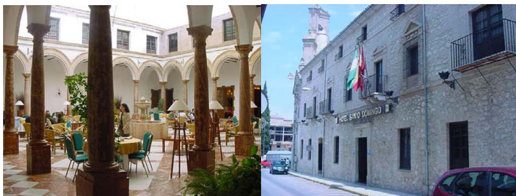
Foto 9.1: Hotel HUSA Santo Domingo ****. Antiguo Convento de Nuestra Señora de la Victoria. Interior y fachada.
