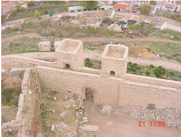
Habilitación del paseo de ronda para la visita pública.
