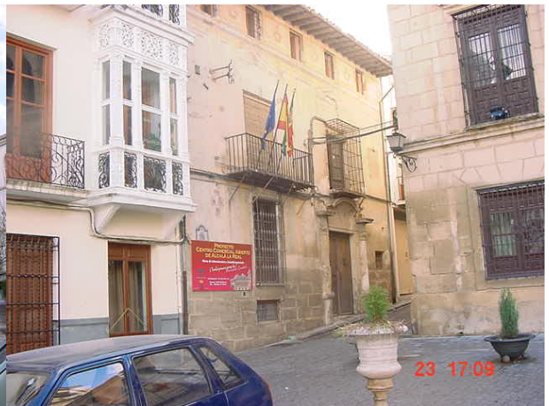
Futuro Centro Comercial. En Rehabilitación. 2000.
