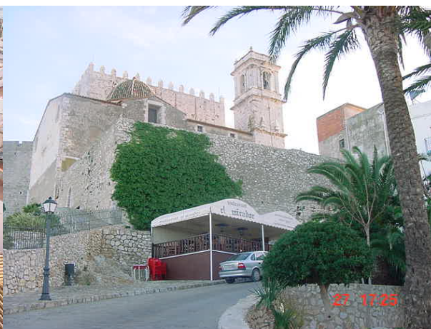
Foto 7.2: La cubierta del depósito de aguas (En Plano EL7C). Zona de esparcimiento.
