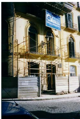
Obras en la Casa Natal de Picasso. Sede de la Fundación Picasso.
