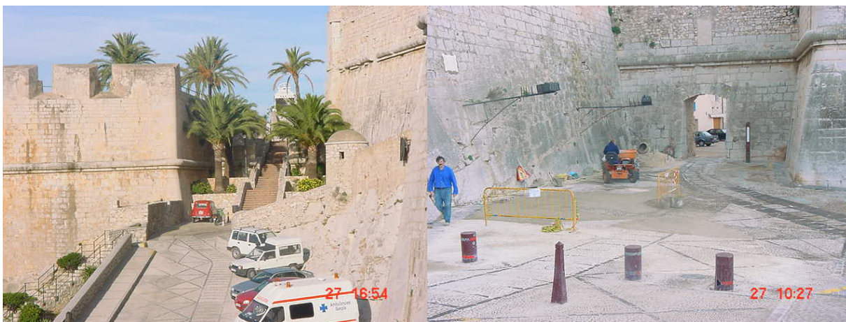
Foto 7.3: La subida del Portal Fosco y entorno (En plano EL15). Obras en el acceso. Pilonas retráctiles situadas al comienzo de la subida. Tráfico restringido y Recorrido peatonal.
