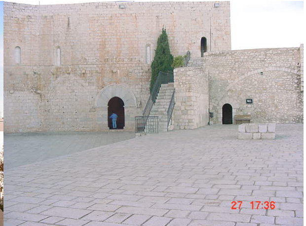
Rehabilitación del Patio de Armas como zona de esparcimiento.
