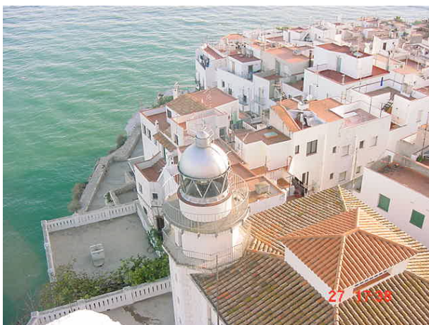
Foto 7.1: Las Terrazas sobre Batería del Terraplén o Rincón y Almacén de Pólvora (En plano EL9) y Baluarte Nuevo (En Plano EL10). Recorridos peatonales.
