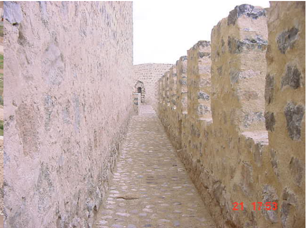
Paseo de ronda restaurado.
