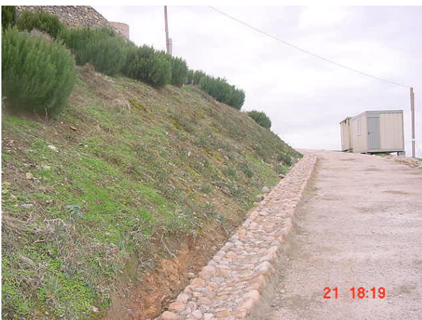
Creación de un acceso nuevo al castillo y canalización del agua por pendiente y ajardinamiento de la subida al Castillo.
