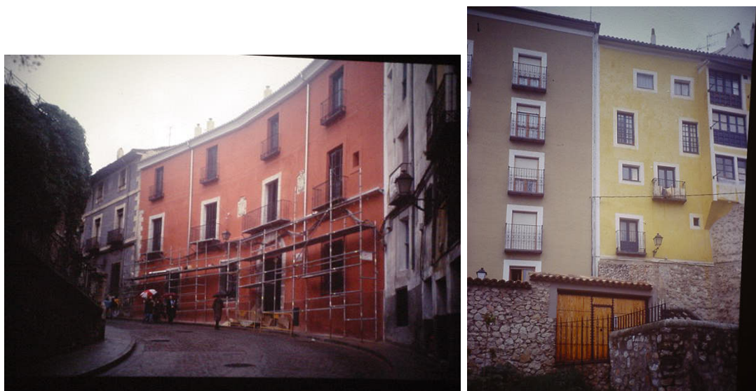
Foto 5.10: Rehabilitación de fachadas. Enterramiento de cableado.
