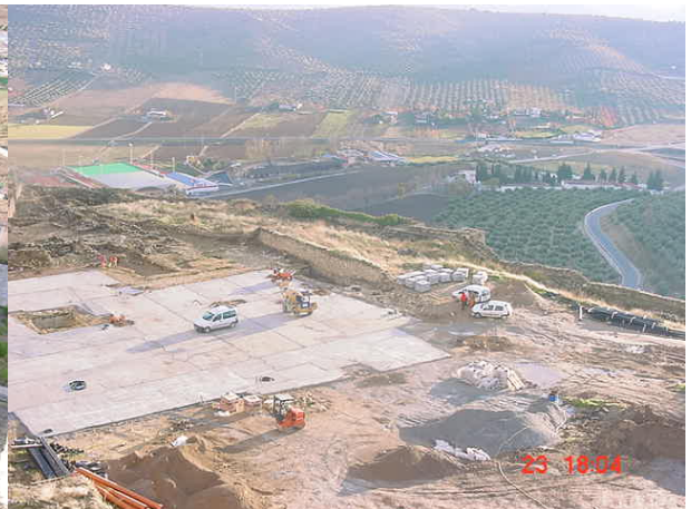
Obras en la fortaleza. Recuperación entorno I. Abacial.
