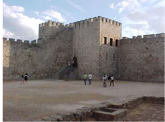
Patio de Armas y Aljibes del Castillo de Trujillo
