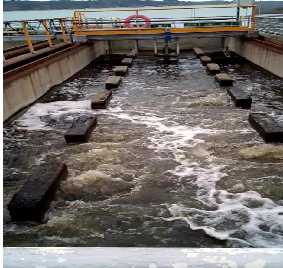
DESARENADOR-DESENGRASADOR POR FLOTACIÓN AIREADA
