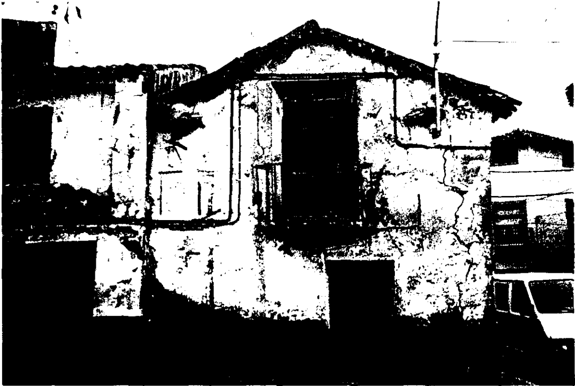
Vivienda construida con la técnica del tapial con dos tirantas aspadas
