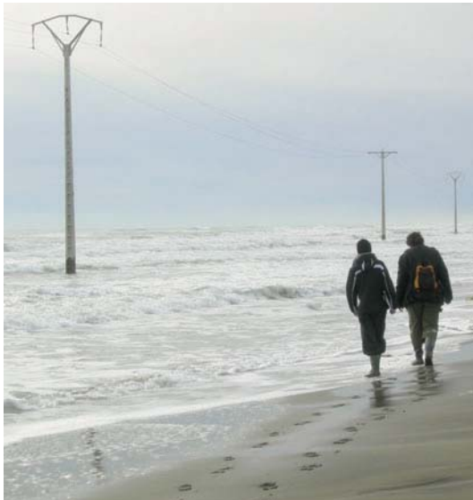
Fig. 11. Tendido eléctrico que recorre en sentido longitudinal la barra del Trabucador en el tramo en que llega a encontrarse en la zona de batida del oleaje por erosión y retroceso del perfil de la playa.
