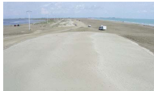
Fig. 13. Arena dejada sobre la flecha del Trabucador en 2005, a expensas de los procesos naturales de redistribución del sedimento, para paliar la erosión que sufre la flecha.
