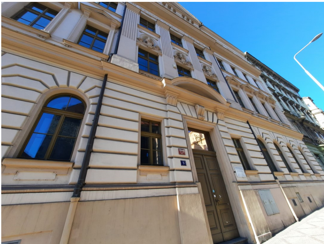
Obr. 2 Budova Ženského výrobního spolku, Resslerova 1940/5, Nové Město (zdroj: autorka)
