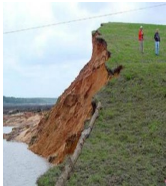
Obr. 12 Protržená hráz Big Bay (převzato Keith, 2004).
