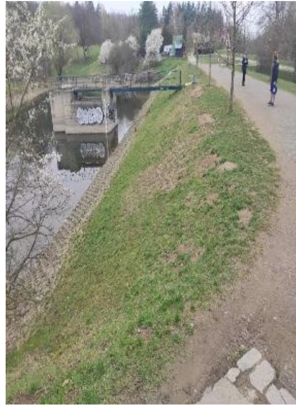
Obr. 15 Návodní svah hráze.
