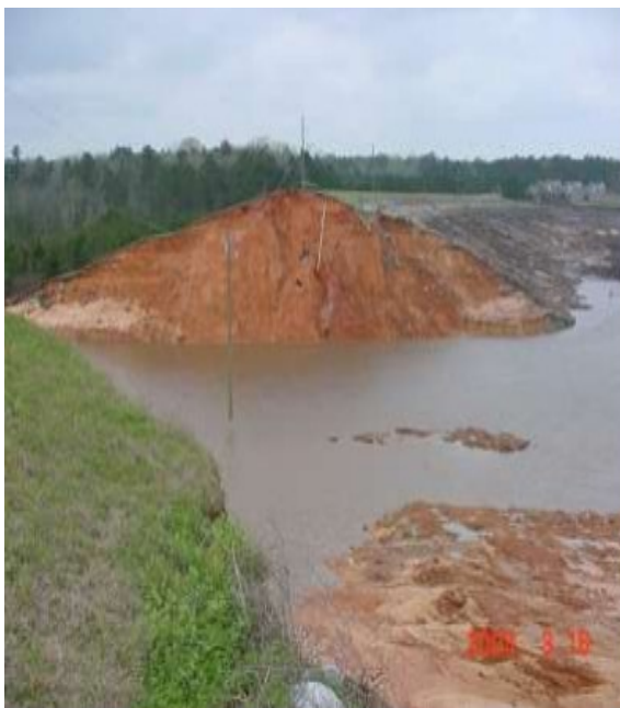
Obr. 11 Protržená hráz Big bay (převzato Keith, 2004).
