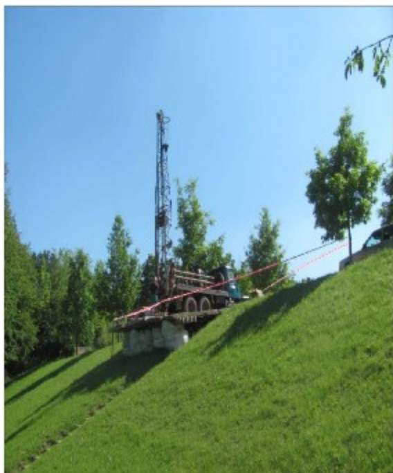
Obr. 20 Vrtná souprava UGB 50M během vrtných prací v prostoru hráze.
