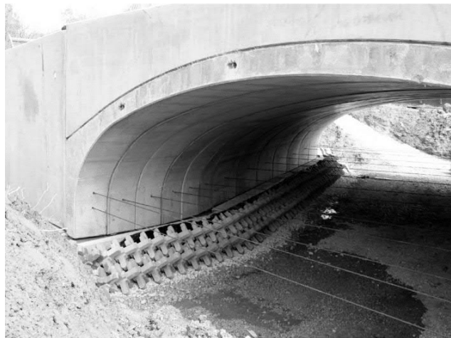
A-JACKS PARTIAL INVERT N.T.S.
