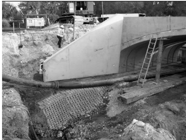
ARMORFLEX PARTIAL INVERT N.T.S.
