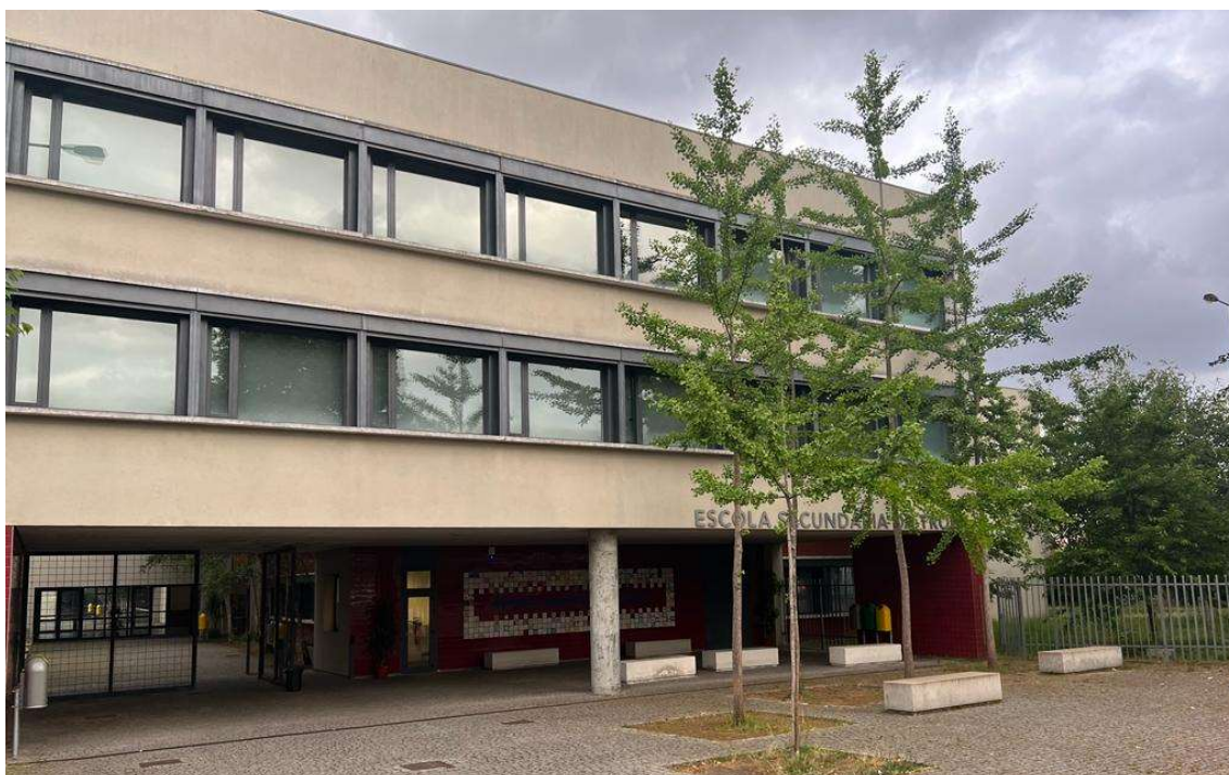
Figura 1 Fachada Principal da Escola Secundária da Trofa
