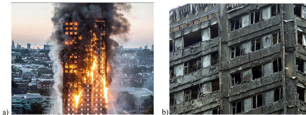
Figura 2.4 - a) Incêndio na Torre Grenfell e b) Estrutura após o incêndio [21]
