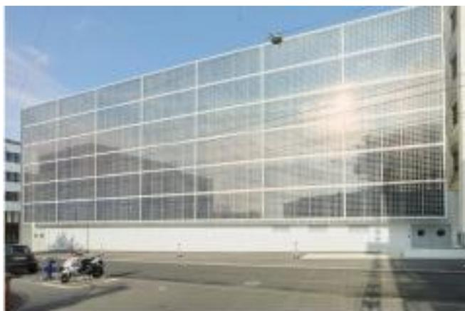
Figura 3.14 - Fachada de edifício construída com painéis fotovoltaicos [71]
