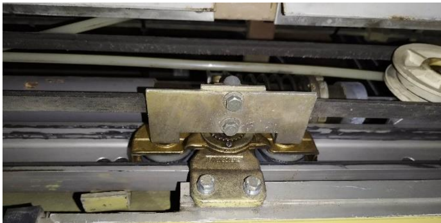
Figura 30- Mecanismo de suspensão.
