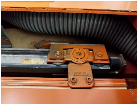
Figura 4- Carrinho de suspensão (Portas de Salão).
