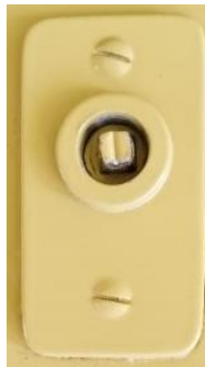
Figura 29- Quadra de bloqueio manual.
