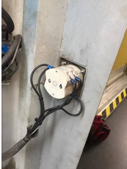
Figura 1- Comutador de Fecho de Chave (Portas de Acesso).
