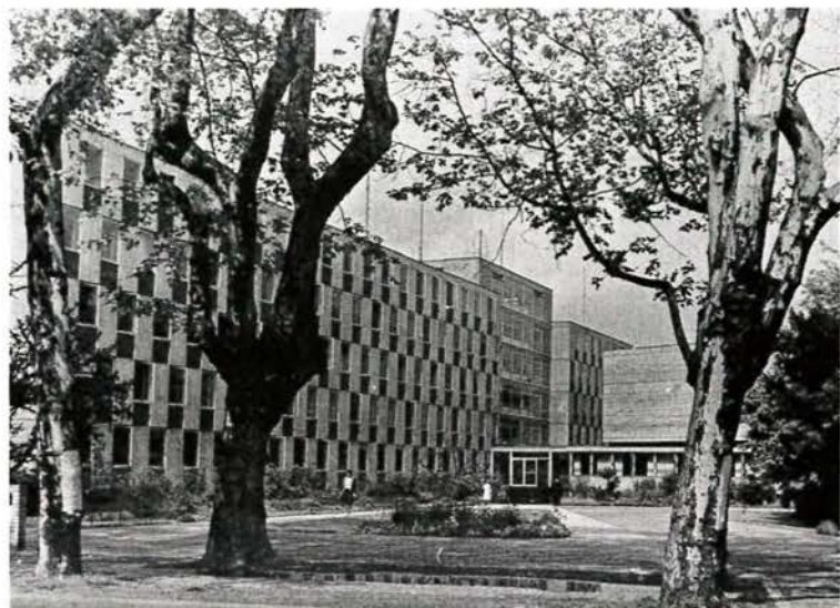
Figura 1.—Offenbach, República Federal de Alemania. Oficina Central del Deutscher Wetterdienst, inaugurada en el otoño de 1957. Un edificio aparte acoge actualmente las divisiones sinópticas, de investigación y de telecomunicaciones, así como el centro de cálculo.
