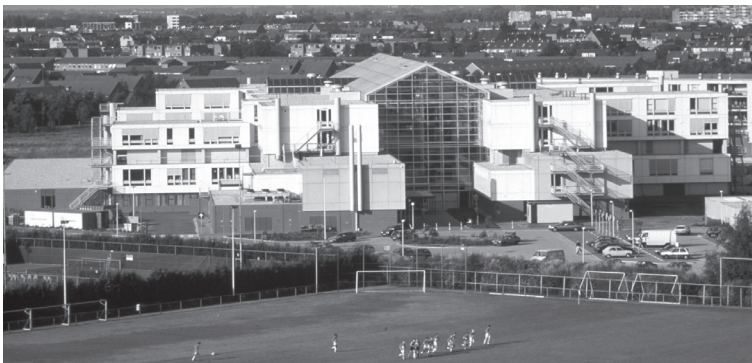
Figuur 1.1 Zuidgevel IJsselland Ziekenhuis
