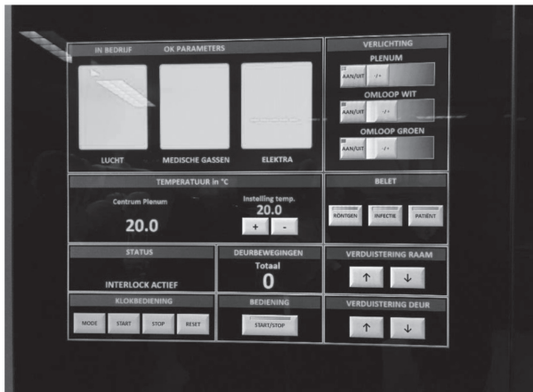
Figuur 5.20 Bedieningspaneel van een ok
