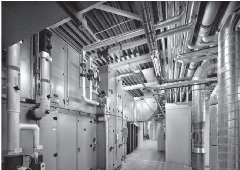
Figuur 5.12 Technische laag Amsterdam UMC, locatie De Boelelaan
