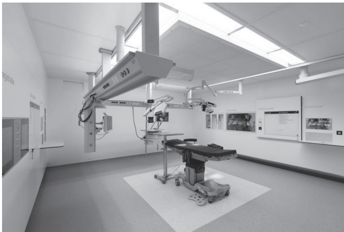
Figuur 5.19 Plenum boven de operatietafel
