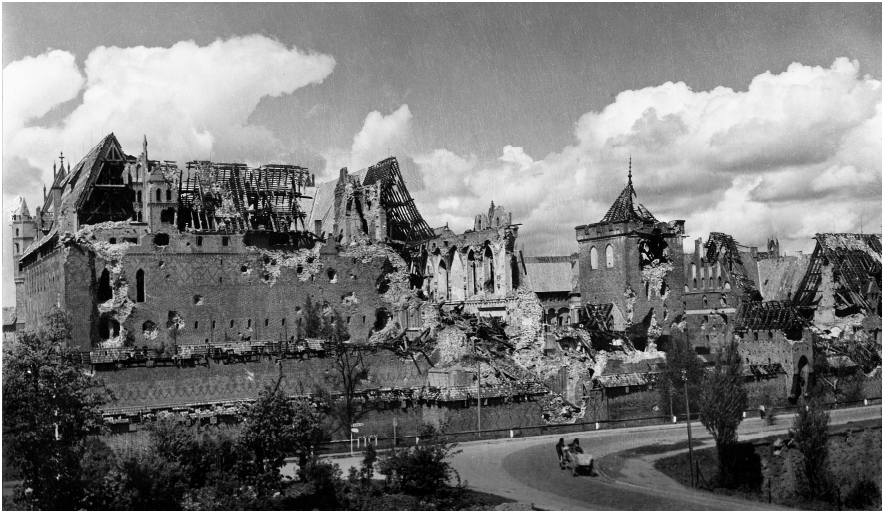
Fot. 7. Zniszczenia wojenne zamku – w centralnym miejscu zawalony kościół NMP (ok. 1946 r.) Źródło: Archiwum Muzeum Zamkowego w Malborku
