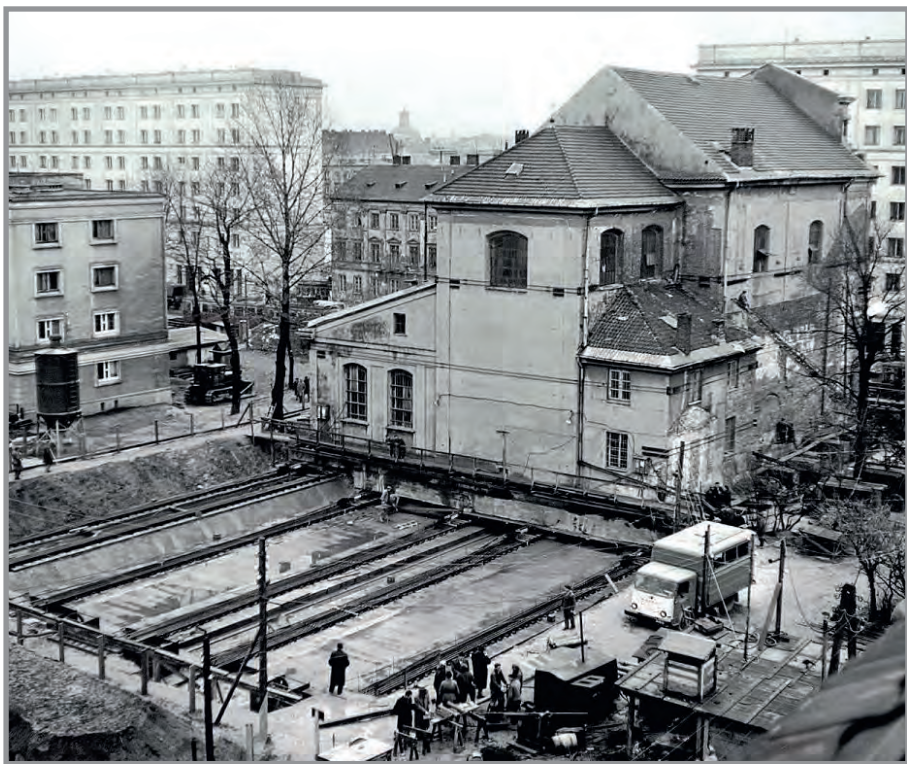
3. Przesunięcie kościoła na Lesznie, 1962, fot. domena publiczna
