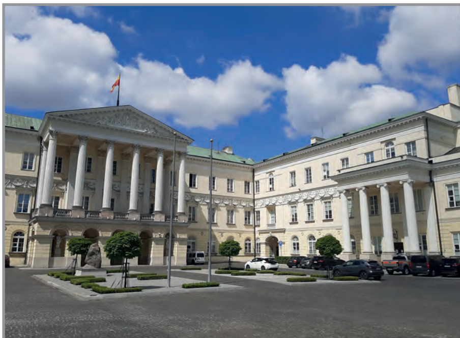
11. Pałac Leszczyńskich-Potockich przy placu Bankowym (obecnie Mazowiecki Urząd Wojewódzki w Warszawie), fot. autorka, 2022
