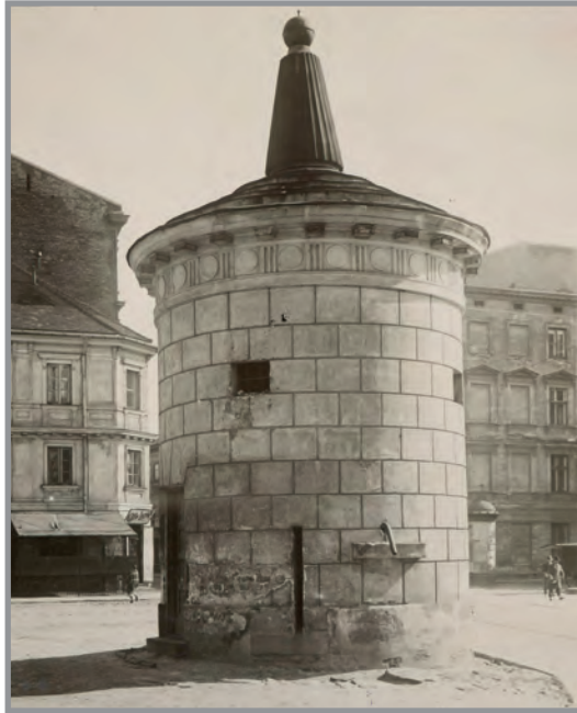
7. Wodociąg na Tłomackim (tzw. „Gruba Kaśka”), 1926, Biblioteka Narodowa, fot. domena publiczna
