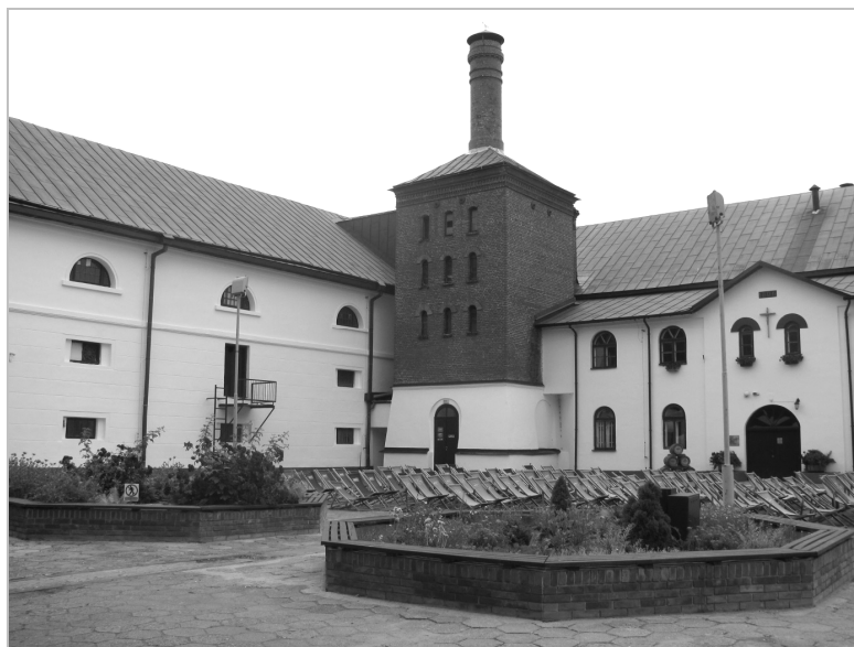
Fotografia 2. Browar w Zwierzyńcu – widok na dawny magazyn, słodownię i warzelnię Źródło: zasoby własne
