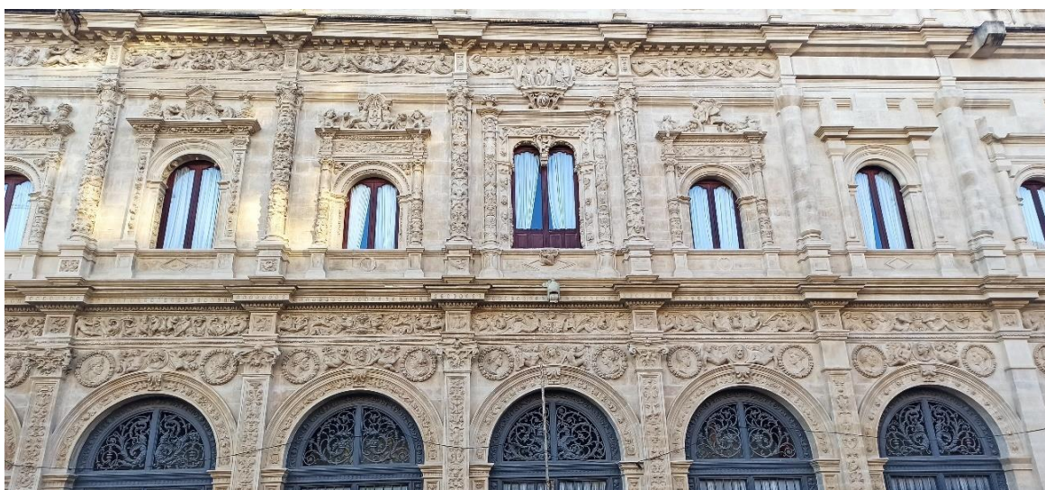
Fig. 163. Fachada renacentista del Ayuntamiento de Sevilla, ca.1527.
