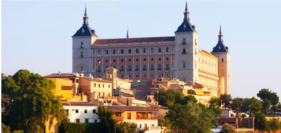
Fig. 49. Alcázar de Toledo (España), transformado a partir de los años 30 del siglo XVI por los arquitectos Alonso de Covarrubias, Francisco de Villalpando y Juan de Herrera.
