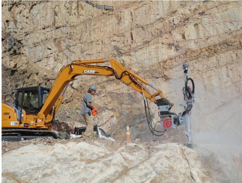
Ilustración 2. Trabajo con perforadora TEI. Fuente: la empresa
