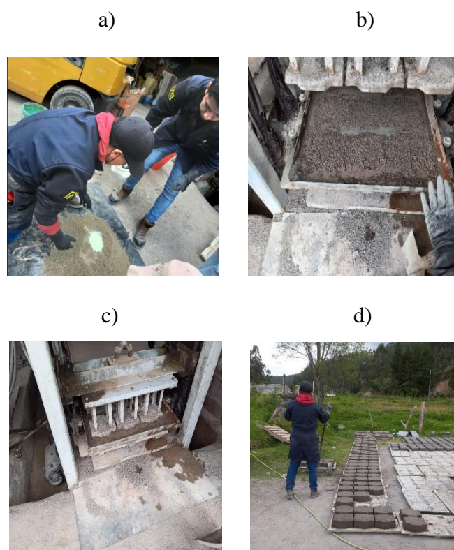
Figura 5. Fabricación de adoquines. a) mezcla con aluminato de estroncio y cuarzo. b) relleno de material en la prensa. c) vibro – compactado. d) apilación de adoquines
