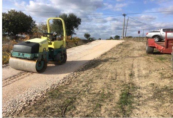
Figura 6 Terraplanagem na Beselga
