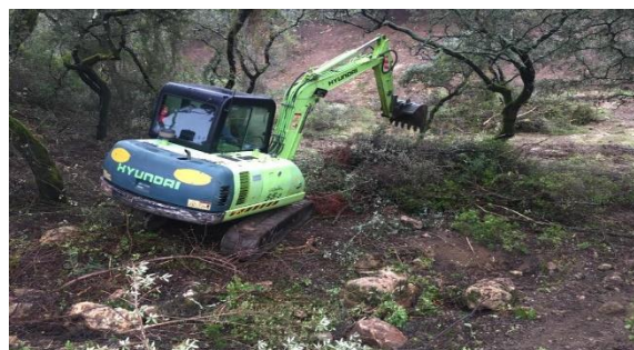
Figura 4 limpeza com a giratória
