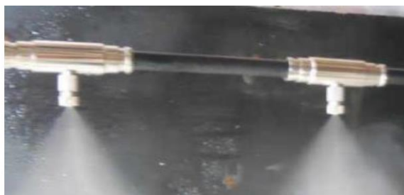
Figura 12 - Sistema de nebulização por alta pressão
