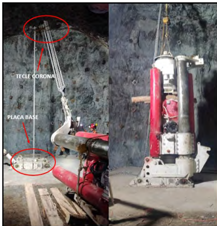
Figura 26. Traslado e Instalación de proyecto CM RB 650
