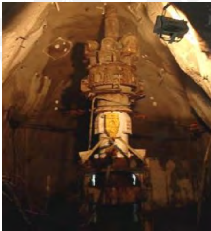
Figura 2. Proceso de perforación Blind Hole
