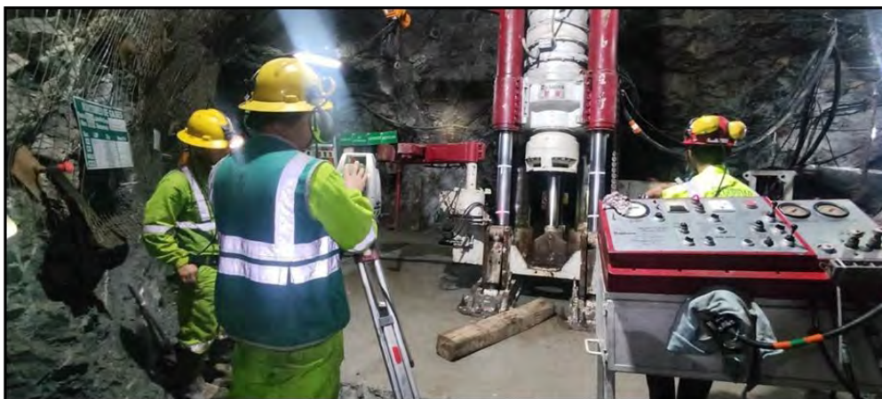
Figura 28. Nivelación topográfica de proyecto CM RB 650
