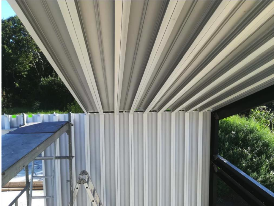
Figura 34. Unión entre paneles de muro y paneles de cubierta. Fuente: Patricia Liñares Méndez.
