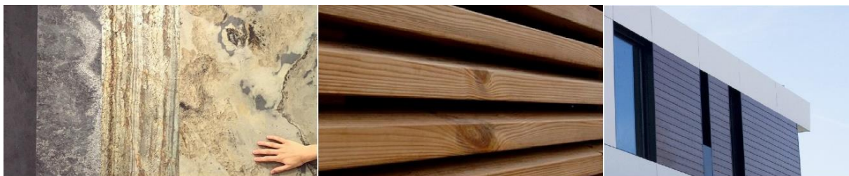
Figura 38. Posibles acabados de fachadas hastiales. De izquierda a derecha: panel de piedra natural, madera termotratada y cedral. Fuente: Proyectopía S.L.
