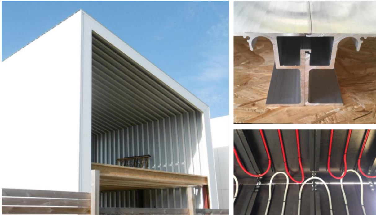
Figura 10. Izquierda, aplicación del sistema en una obra en construcción. Derecha, arriba, detalle de la unión de dos paneles aluminio; abajo, circuito para captación solar en paneles de aluminio. Fuente: Proyectopía S.L.
