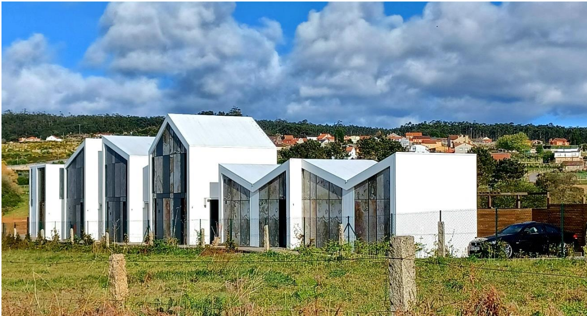
Figura 13. Apartamentos turísticos construidos con el sistema constructivo modular de aluminio extrusionado. Fuente: fotografía propia.
