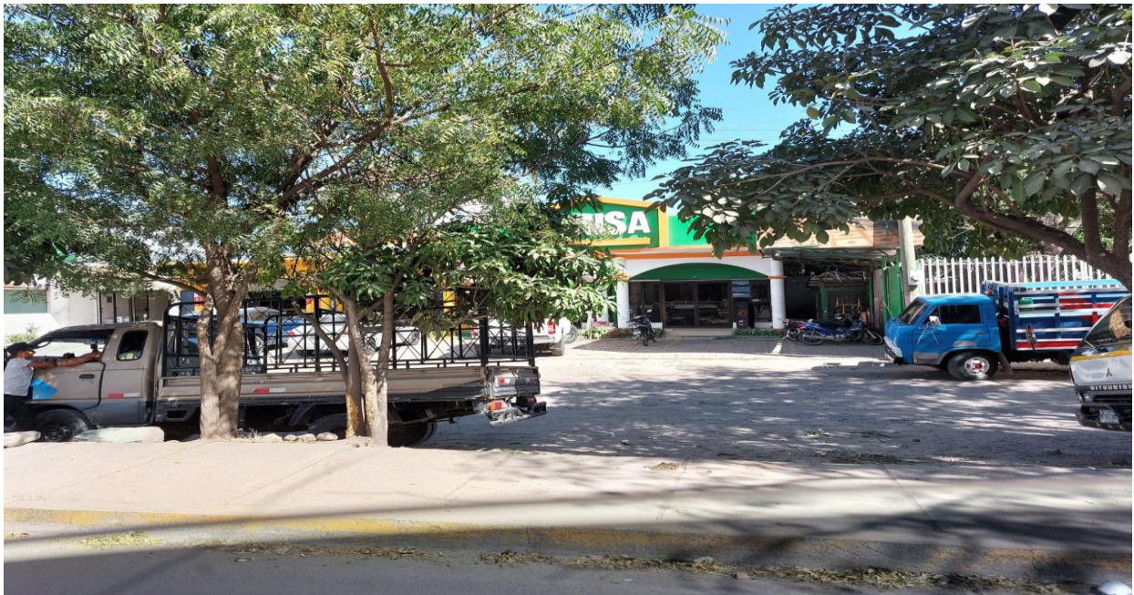
Ilustración 18 - Instalaciones de la sucursal, desde otro extremo de la carretera panamericana
